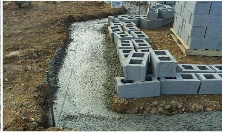
La construcción de dicha cimentación se compone de mano de obra, materiales y maquinaria para hacer la zanja perimetral siempre que se trate de un terreno llano.
