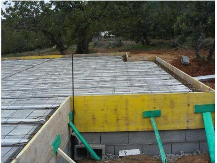
Corresponde a la normativa de CTE. Losa de hormigón con doble mallado y zuncho perimetral con hormigón clase H250, dejando ya preparadas la pre instalación de fontanería para recibir los desagües y entrada de agua, así como la entrada de luz. Dicha cimentación irá previamente aislada con lámina de plástico o pvc semirrígido para evitar el paso de la humedad del subsuelo, con relleno previo de gravón de 3cm de diámetro para proporcionar un efecto previo de ventilación.
